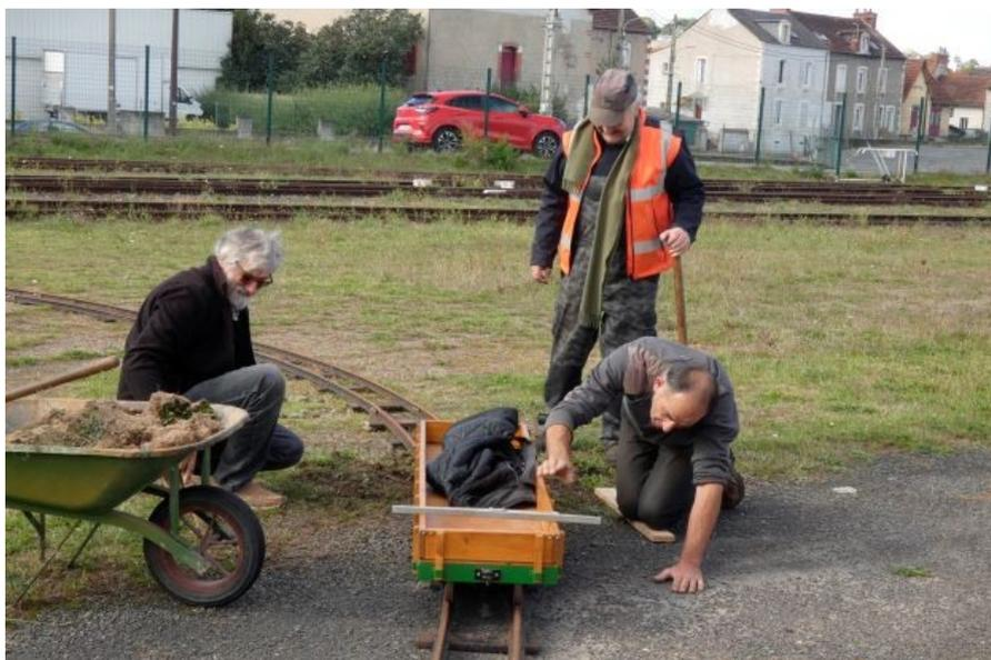
Le réseau restera en place définitivement, les essais de roulement ont donné lieu à un recalage de la voie dans les parties courbes, des wagons avec un empattement court devraient être construits durant le prochain hiver.
