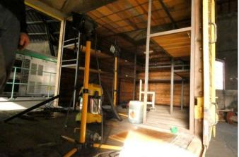
Remplacement de lames de bois détériorées, remise en état de l'intérieur et ponçage des éléments métalliques Extérieurs : les travaux avancent !
