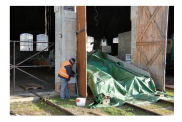
Lors des derniers coups de vent, les portes provisoires montées sur la deuxième travée de la rotonde, ont été endommagées. Pour des raisons de sécurité, ces portes sont en cours de démontage.
