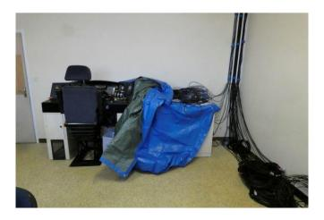
L'aménagement de la salle se poursuit, pose radiateurs électriques, mise en place de panneaux bois sur fenêtre extérieure coté rotonde, passage des câbles de raccordement entre armoire de contrôle et pupitre.
