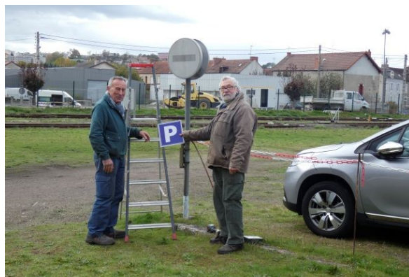
Stationnement sur site : pose de la signalisation
