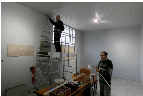
Salle du musée : pose des baguettes de finition après mise en place du faux plafond
