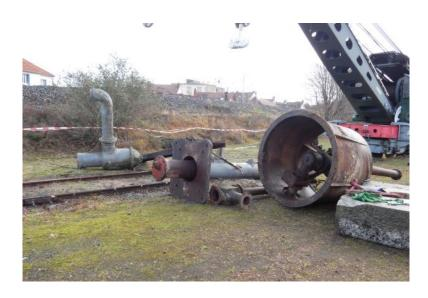
Une étude est actuellement en cours pour la remise en place sur notre site des deux grues PLM et PO arrivées en fin d'année dernière de Cosne sur Loire. La grue PLM devra être remonté à proximité des voies d'entrée du dépôt et sera fonctionnelle pour l'alimentation en eau des machines à vapeur de passage sur site, la grue PO quant à elle ne sera pas fonctionnelle.
