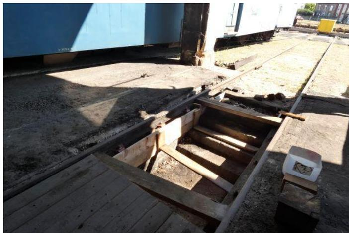
Un tronçon de voie à l'entrée de la rotonde, a fait l'objet de réparation afin de rehausser le rail et renforcer sa fixation sur l'entrée de fosse. Pour cela un coffrage a du être réalisé et un béton coulé.
