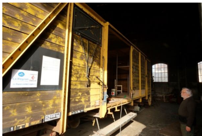
G40 : travaux de menuiserie en extérieur, remplacement des lames détériorées et réfection du plancher intérieur.
