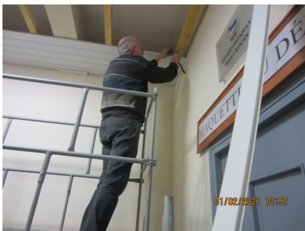
Espace musée : les travaux dans le hall d'entrée se poursuivent, le plafond est en cours de finition. Documents et matériels pour le musée sont de plus en plus nombreux à rentrer.
