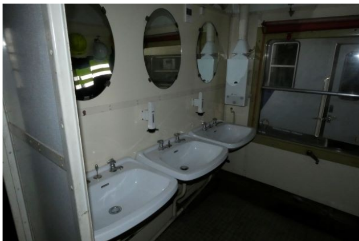
Voiture de cantonnement : poursuite des travaux de remise en état intérieur, les compartiments sont rénovés les uns après les autres.
